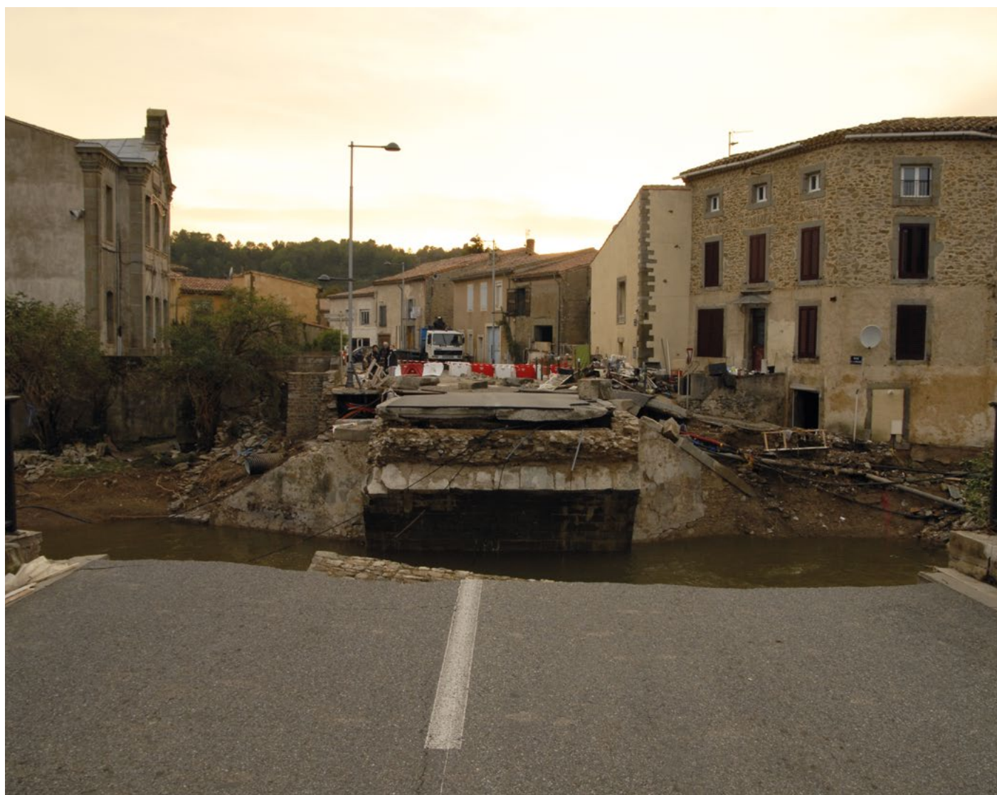
Pont de Villegailhenc détruit - Crues de l'Aude de 2018 © IRMa, Mathias LAVOLÉ, 2018
